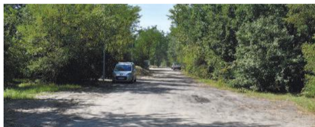
Nowa nawierzchnia na Sikorskiego
