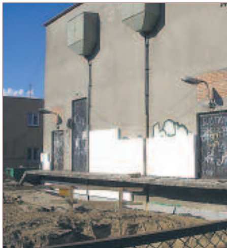
▲ Trwa przebudowa systemu odprowadzania wód deszczowych
